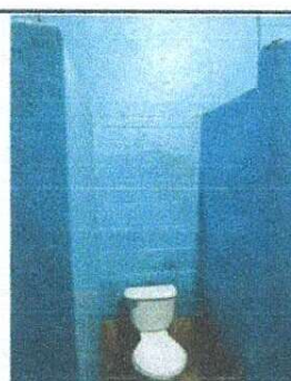
Foto 6: SUSTITUCIÓN DE SERVICIOS SANITARIOS Y SUS ACCESORIOS
