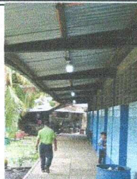
Foto 2: PRIMER MÓDULO DEL ESTABLECIMIENTO Y ÁREA VERDE, REPARACIÓN DE SISTEMA ELÉCTRICO
