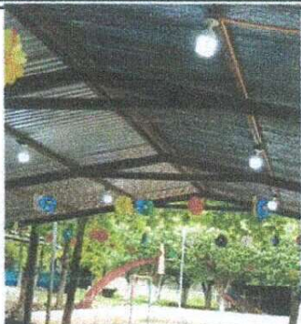
Foto 1: SUSTITUCIÓN DE SISTEMA ELÉCTRICO DE SALÓN
