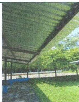
Foto 5: TECHADO DEL SALÓN. SUSTITUCIÓN DE LÁMINA, POR LÁMINA TROQUELADA ALUZINC CALIBRE 26
