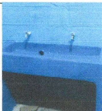
Foto 3: SUSTITUCIÓN DE LAVAMANOS
